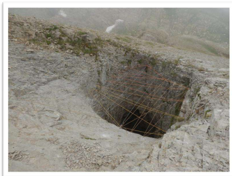
Trabajos de cubrimiento con rafia de la cavidad B-7
